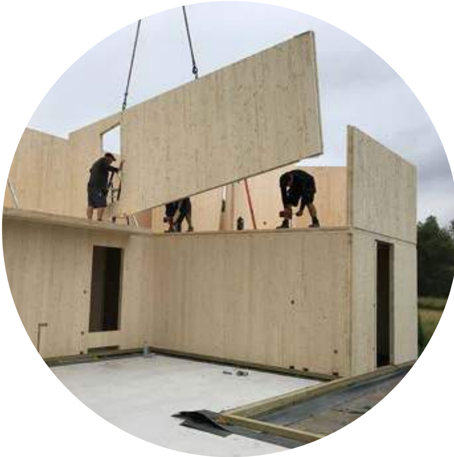
Constructie van een (massief houten) woning. Bron: Trouw, 2019.
