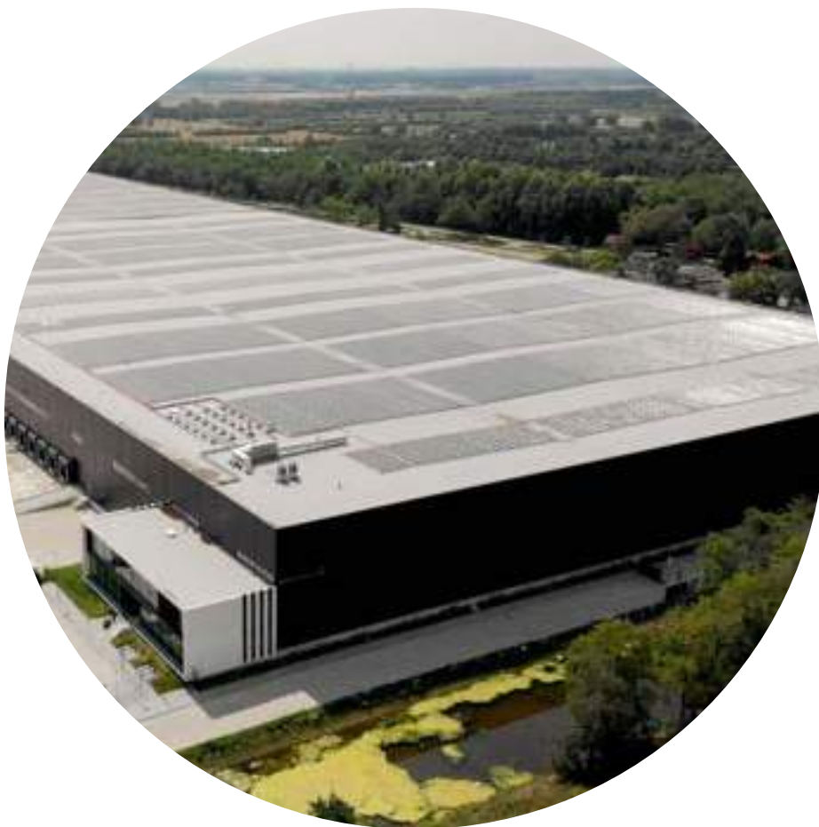
Zonnepanelen op het dak van DPD op bedrijventerrein Westfields in Oirschot. Bron: Solarmagazine, 2020.
