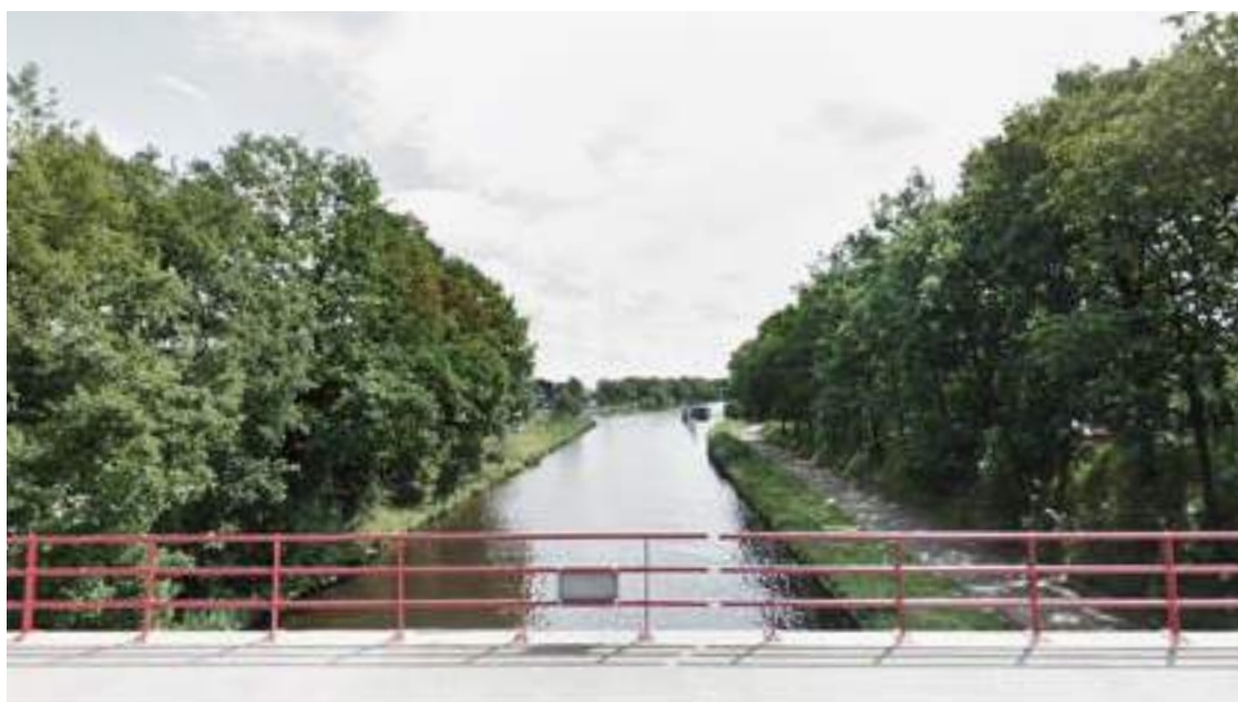
Brug over het Wilhelminakanaal.
